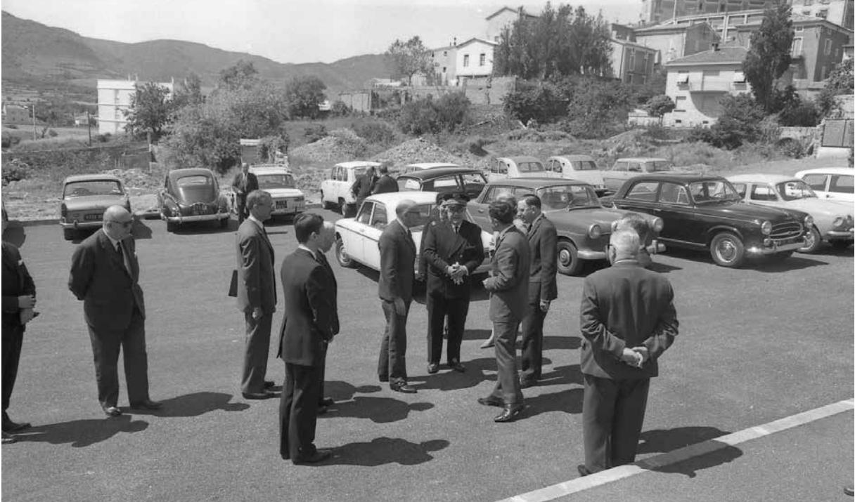
Inauguration du bâtiment des Archives départementales de l'Ardèche, Privas (1966). Archives départementales de l'Ardèche, 41 Fi 10025.
