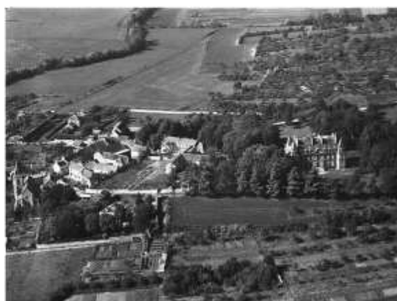
Vue générale de Santeny - photographie aérienne (1954) Fonds Roger Henrard 30F1/A1
