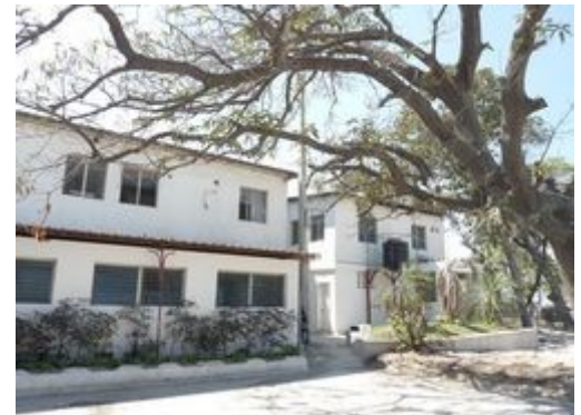
Le bâtiment où sont conservées les archives du MAE. sur le site du Bicentenaire.
